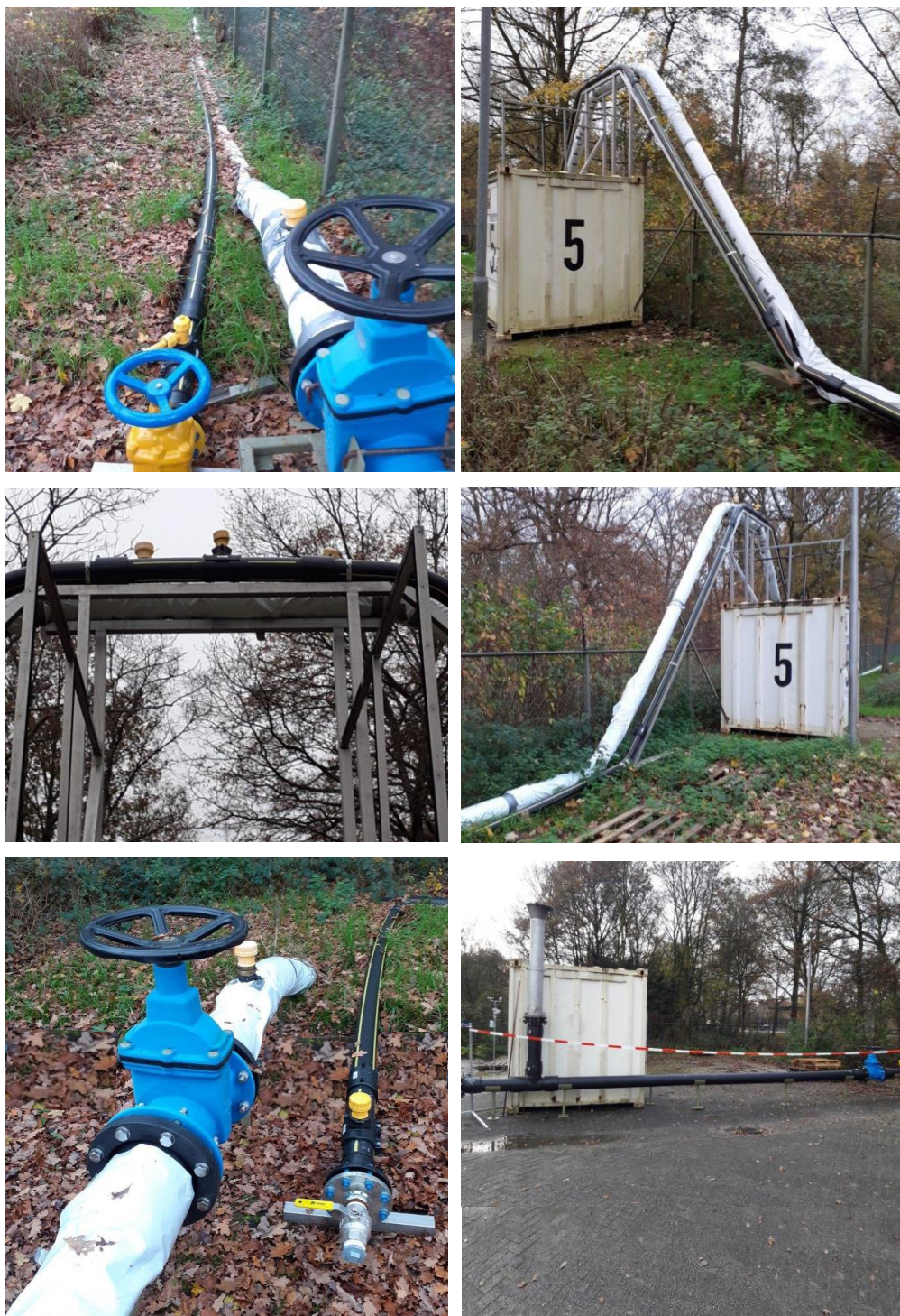
Figuur 4: Enkele foto's van de testleiding Bovenste rij: het intredepunt en de aanstroomzijde brugleiding Middelste rij: de 'brugleiding' en de afstroomzijde brugleiding Onderste rij: (nabij) het uitredepunt en de afblaas DN 200
